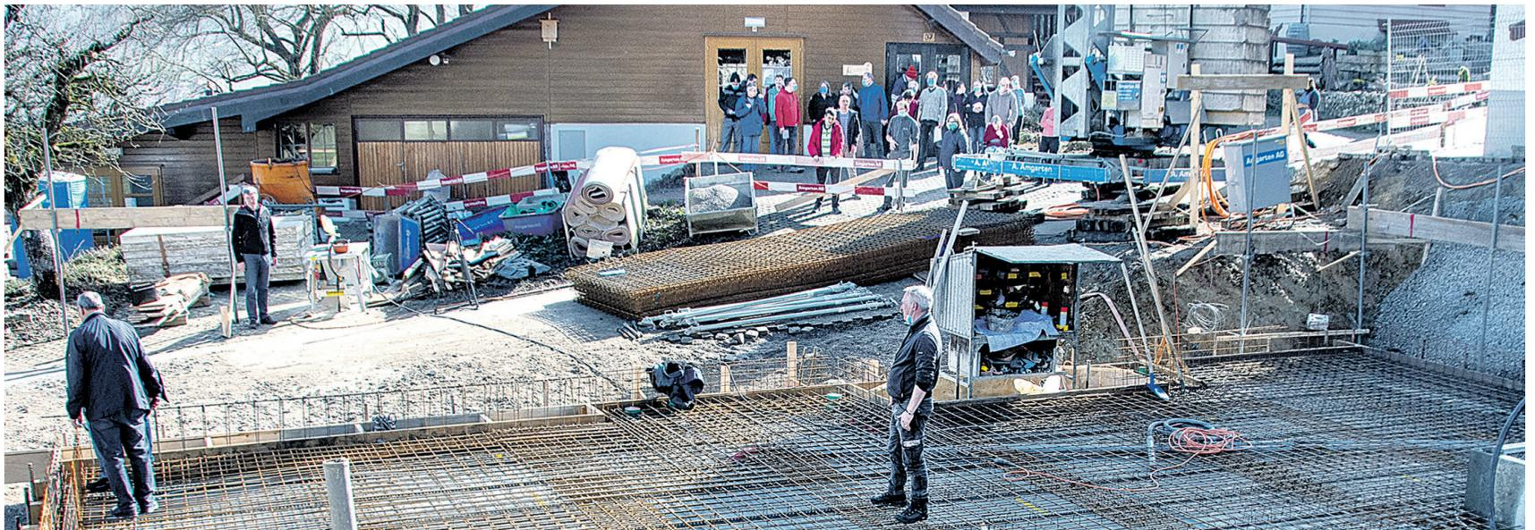
Die Armierung für die Bodenplatte ist gelegt, die Dokumentenkassette darin platziert (ausserhalb des Bildes), der Beton kann gegossen werden.
